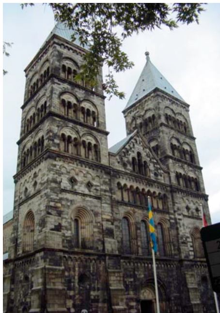
Lund Domkirke. (Foto Bent Jul)
